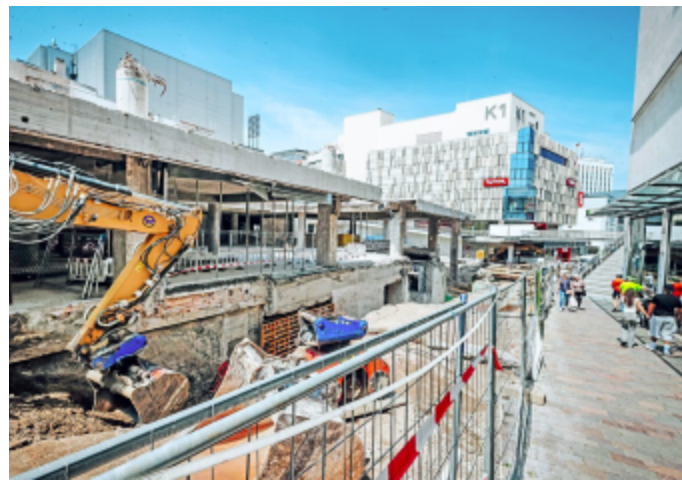
Das ehemalige Kaufhof-Gebäude wird entkernt und einer neuen Bestimmung zugeführt. Hier ein Bild aus dem Juni. Foto: Jörn Hannemann
